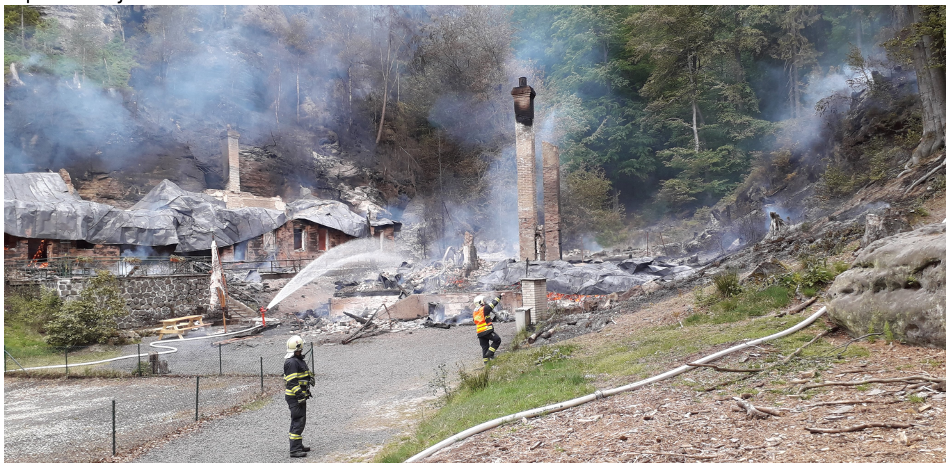
Vyhořelá objekty Na Tokáně dne 22. května 2020 v poledních hodinách. Foto: Tomáš Salov
