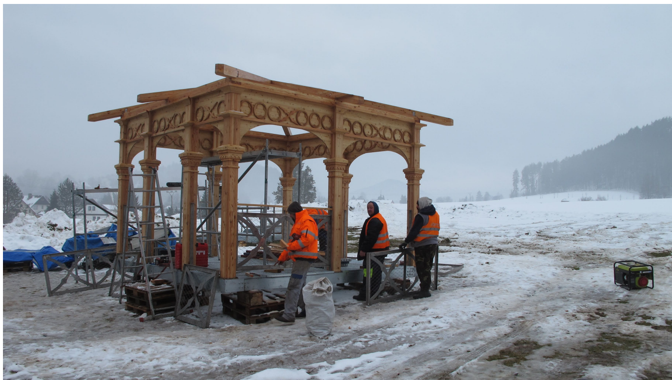
Montáž a oprava práce a oprava altánu Mariiny vyhládky v Jetřichovicích u ozdravovny na vynesení vrtulákem, třídenní před usazením na vrchol skály. Foto: Tomáš Salov
