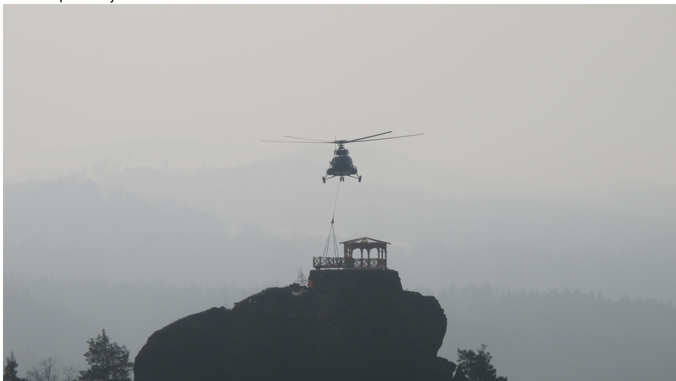
Vrtuln ěk usazuje vyhládkovou plo ěinu p ěed pr ěv ě instalovan ě ěm alt ěnem na Mariin ě vyhl ědce. Foto: Dagmar ěeb ěkov ě
