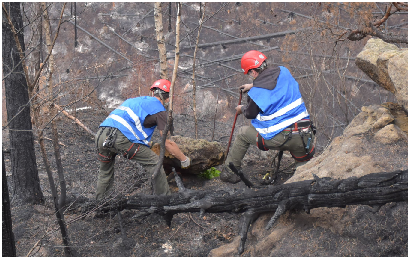
Pracovníci skalné útesy Správy NP shazujú nebezpečné kámeny nad cestou vedúcou k Právnická bránu. Foto: Jan Malák, Česká geologická služba
