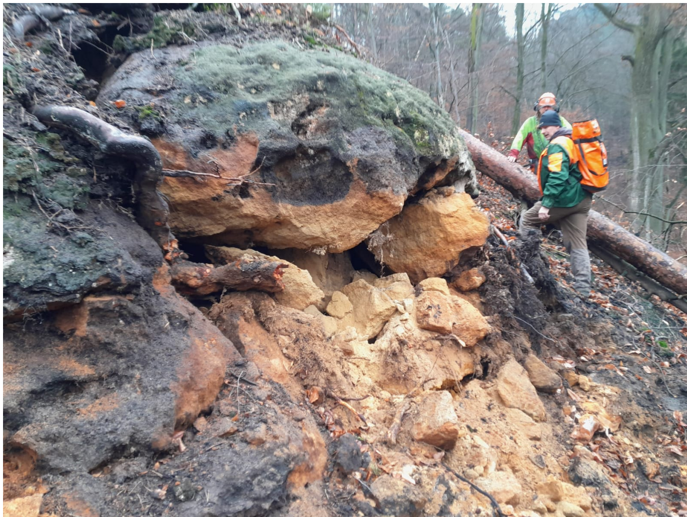
Nebezpečný skalnĚ blok nad cestou k PravĚickĚ brĚnĚ. Foto: Stanislav Feigl
