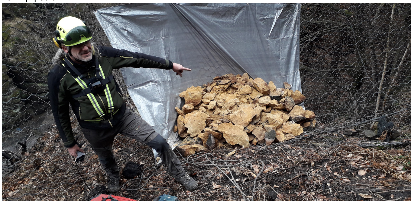
Kámen ve vysokozátáčové bariéře nad zástavbou obce Hájensko po rozebrání na menší kusy. Ty byly uloženy do vybraných partií svahu tak, aby nedocházelo k opětovnému padání do bariéry. Foto: Tomáš Salov
