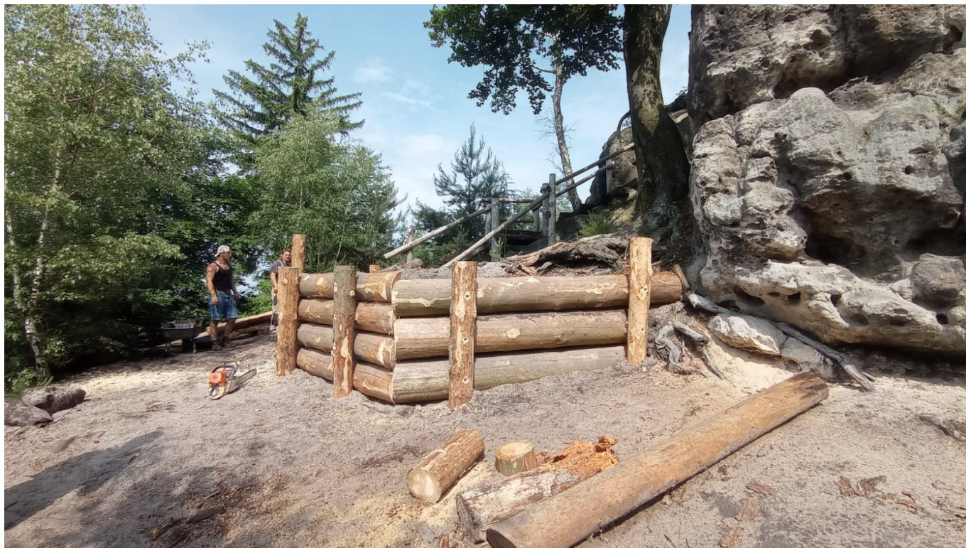
Nová palisáda pod bukem při patě Rudolfova kamene stromu, která je také estetickým prvkem v krajině, prodlouží život. Foto: Miroslav Rohlík
