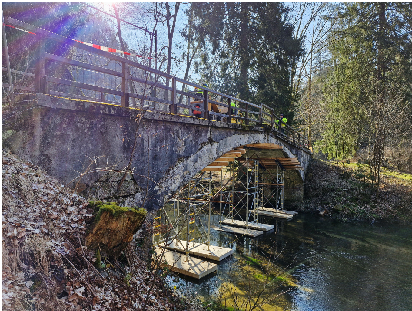
Mostek z roku 1902 na cestě k Dolskému mlýnu je podroben rozsáhlé údržbě. Foto: Tomáš Salov
