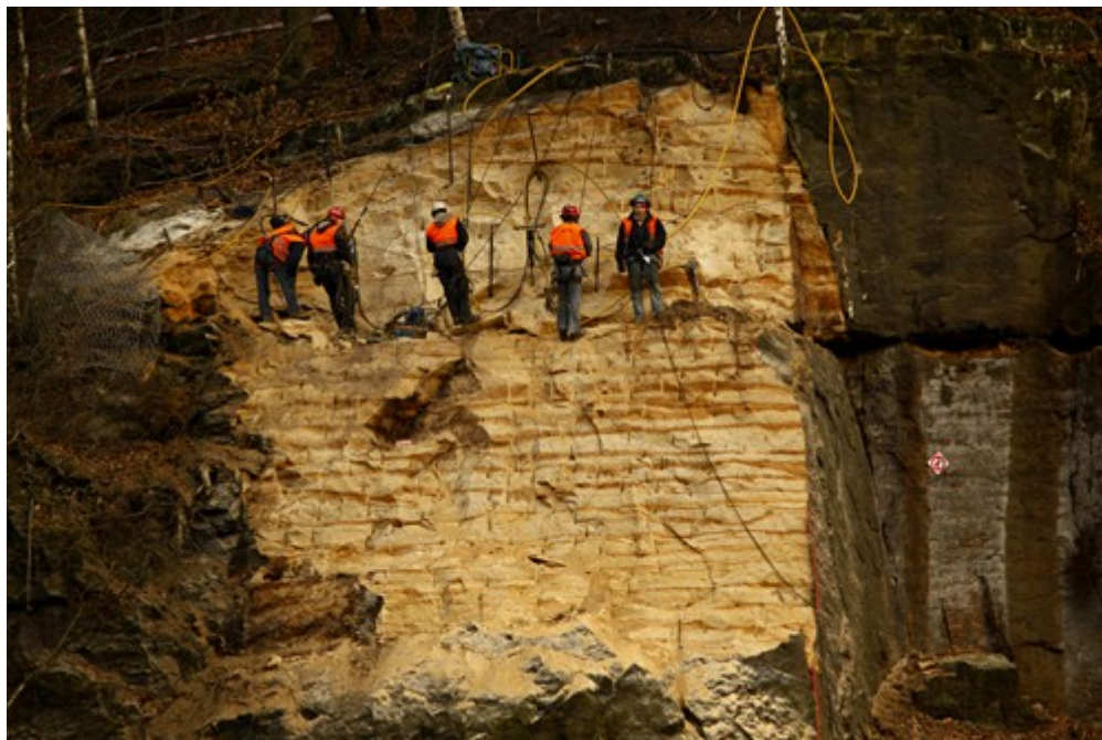
Sanace skaln stny nad mezinrodn silnic v k.. Hensko. Foto: Archiv sprvy NP
