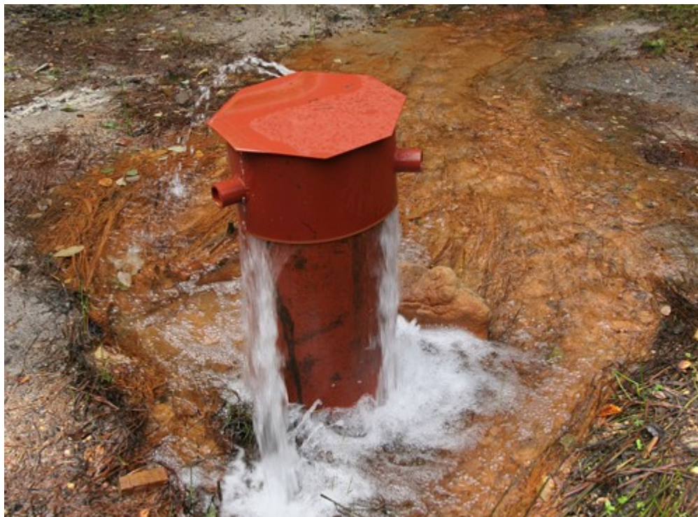
Vrt s tzv. art. zsk. 1/2m p. etokem podzemn. vody. Foto: Zdenk Patzelt
