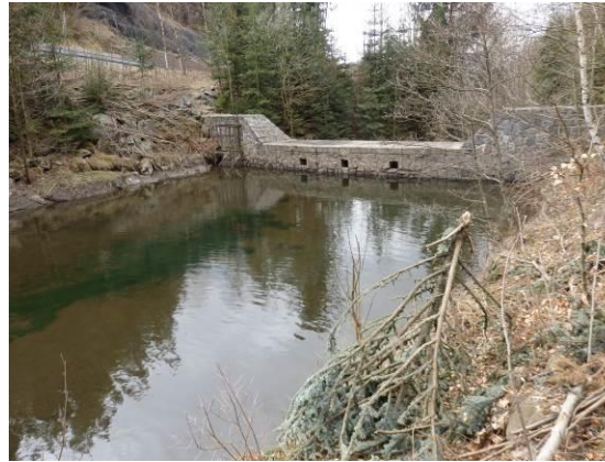
Retenční přehrážka na vodním toku Hluky
