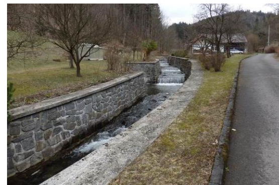
Opěrné zďi v intravilánu obce Hluky
