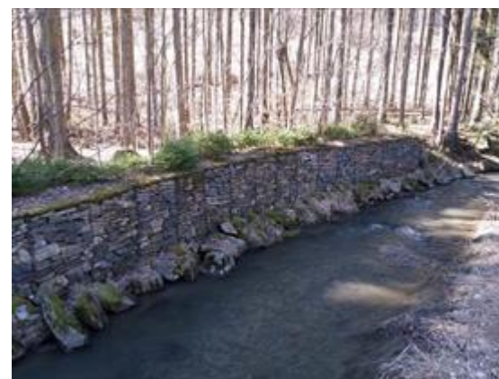
Opěrná gabionová zďď na Hodonínce
