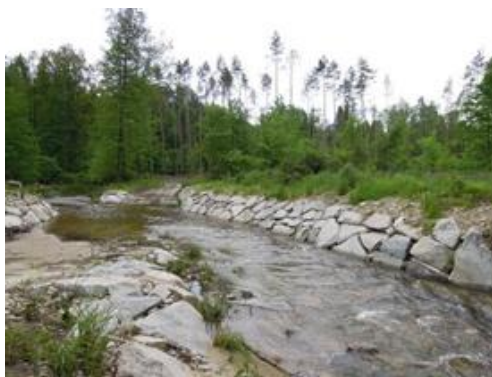
Stabilizace břehů koryta Červeného potoka kamennou rovnaninou
