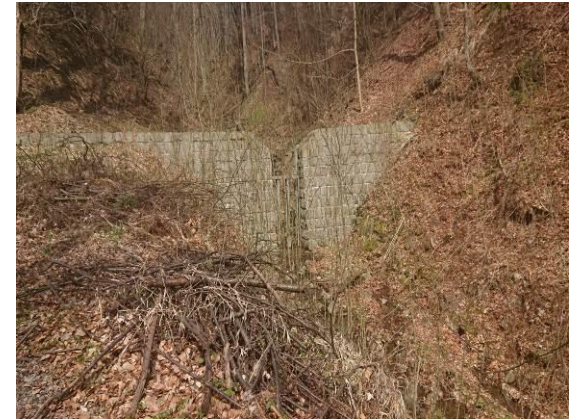
Průčzná retenční přehrážka na Vysutém potoce
