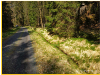
STÁVAJÍCÍ PŘÍKOP U SILNICE ČESKÁ
