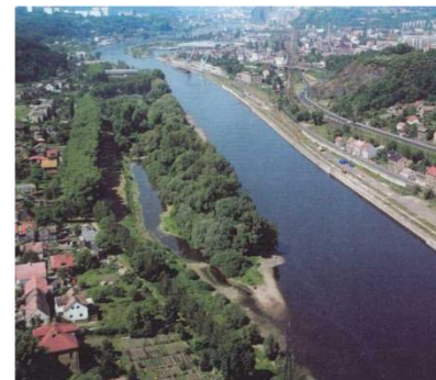
Svádov v Ústí n. L. po výstavbě soustředovacích hrází na konci 19. století (vlevo) a dnes (vpravo).
