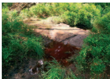
Jedna z přehrázek vybudovaných na Rájeckém rašeliništi. © Jaroslav Semík
