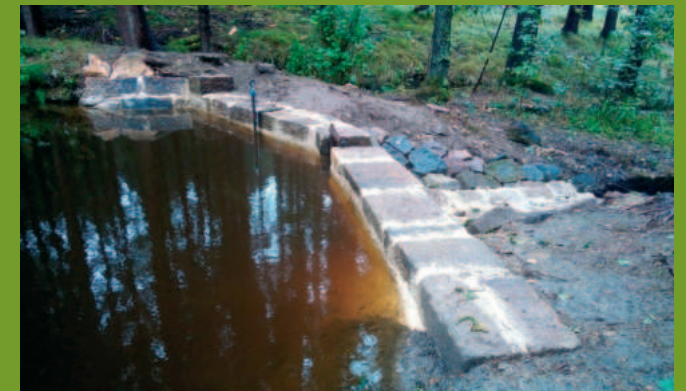
Stav hráze rybníčku po provedené rekonstrukci. © J. Semík
